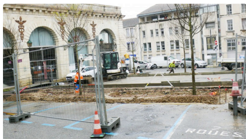
Vue des travaux de plantations et la mise en place des bordures.
