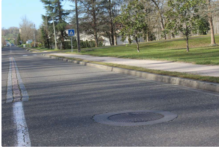
Réfection de la couche de roulement de la RN 524
