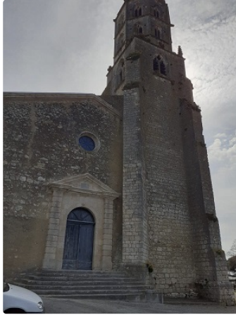
Travaux de mise en sécurité de l'église Saint Michel.
