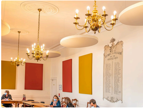
Nouveau : un dispositif acoustique composé de panneaux muraux absorbant le son et d'écrans en forme de soucoupes volantes
