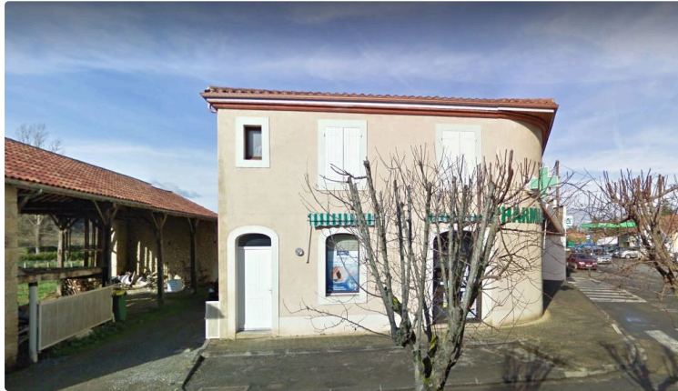
Nouveaux ouvrages à la médiathèque
