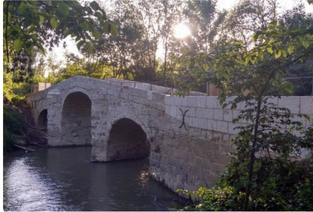
Restauration du pont d'Aurenque
