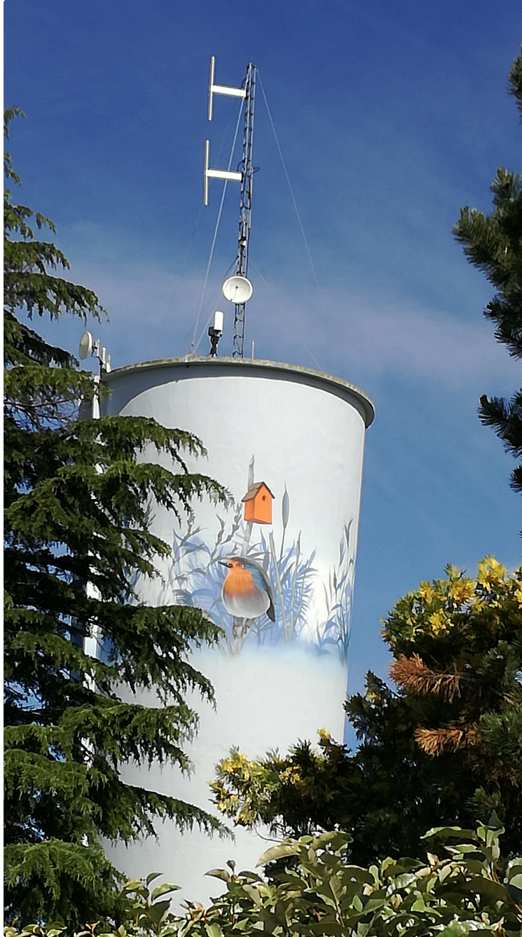
Un peu de poésie picturale sur les murs du château d'eau de Cassemartin
