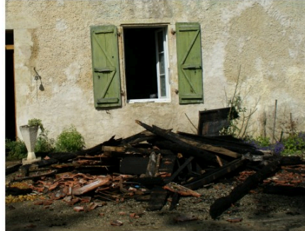
Une maison dévastée par un incendie à Marambat
