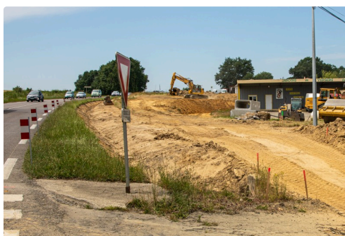
Le haut du chantier
