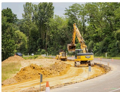
La pelle et le rouleau dans le bas du chantier
