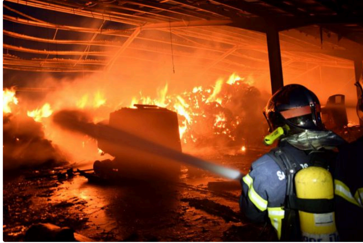
Violent incendie d'un bâtiment agricole de 900 m2
