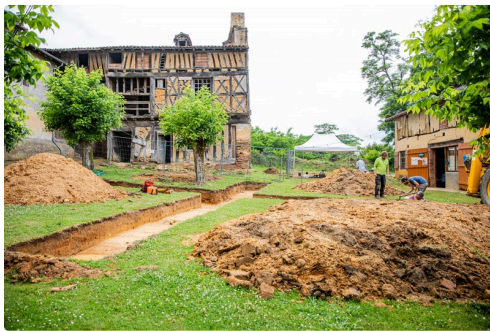
Vue du chantier
