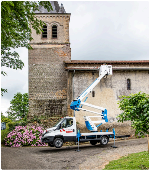
Réfection du toit de l'église de Sainte-Christie
