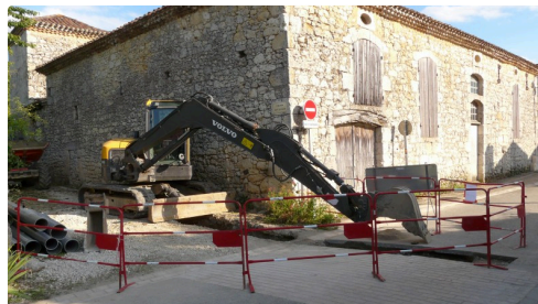
Début des travaux rue Delor.
