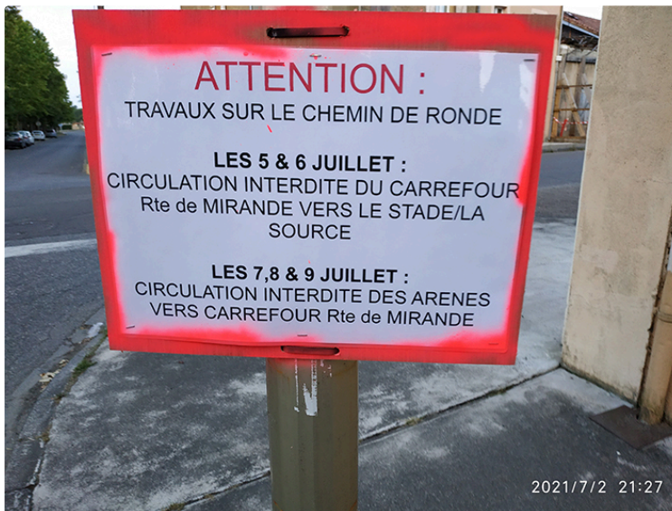
Circulation perturbée, travaux en cours dans la ville
