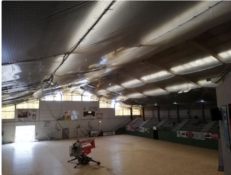
Un chantier impressionnant démarre
