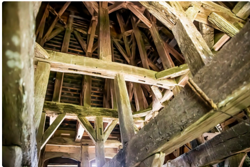
Charpente du sommet du clocher
