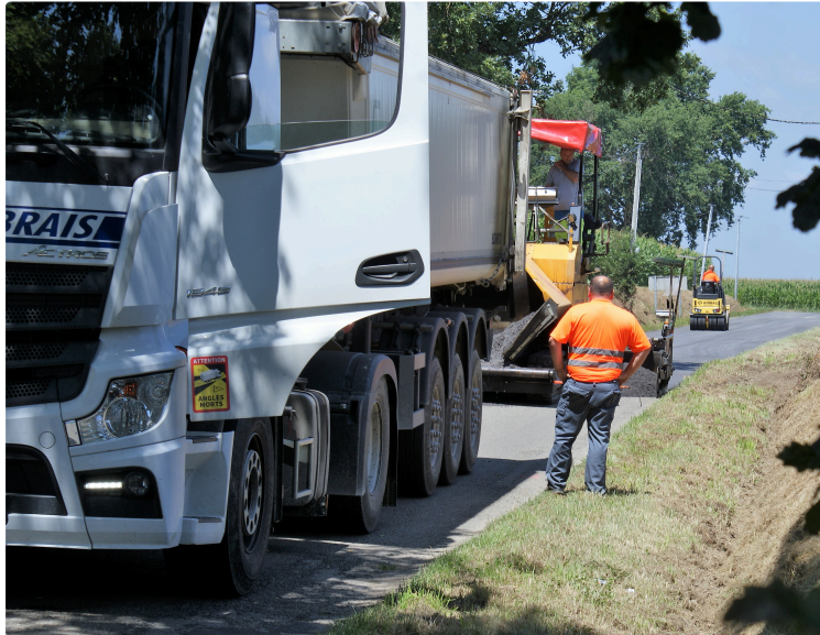
Route de Tasque les travaux ont débuté aujourd'hui
