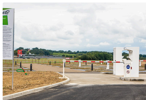
Vue du Parking des Oliviers
