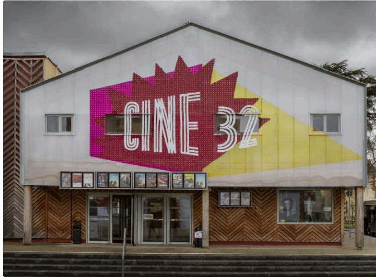
Nouvelles après l'incendie
