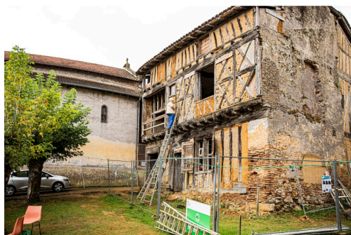
La façade est aussi en réfection
