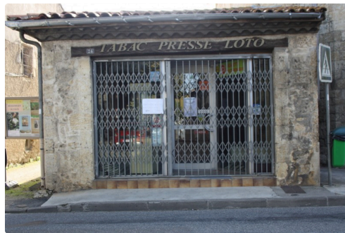
L ancien local qui sera démoli
