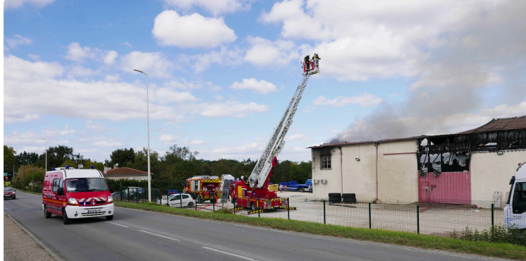
Un violent incendie détruit les locaux de l'entreprise Barrère
