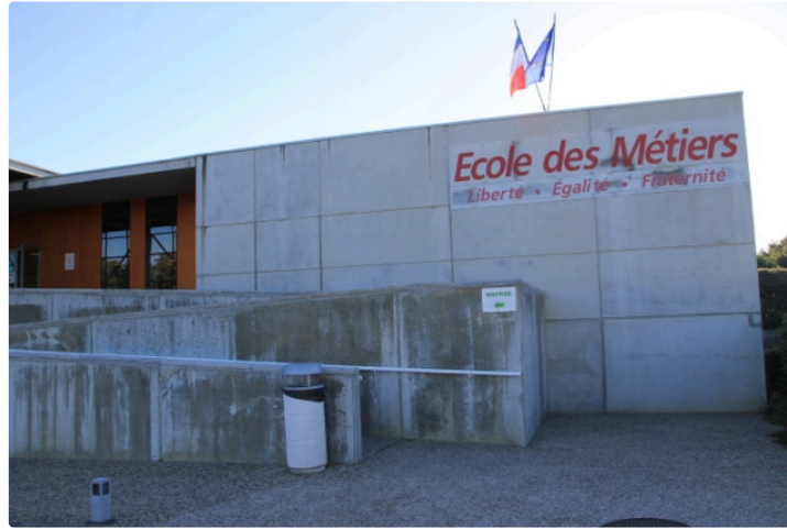
Un nouvel atelier pour la section maintenance agricole
