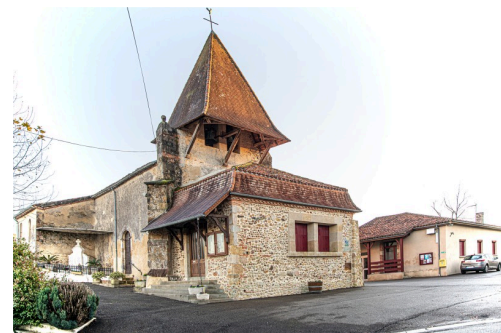
Eglise à Lelin-Lapujolle, avec la mairie au rez-de-chaussée ; à droite, la salle des fêtes
