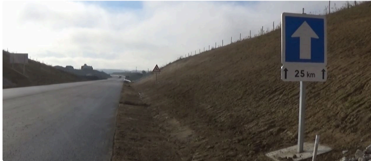
RN 124, déviation de Gimont : la fin des travaux pour le 1er trimestre 2022 ça se précise
