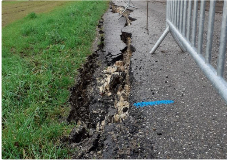
Fermeture d'une voie communale pour des travaux de mise en sécurité
