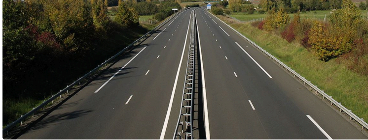
Route Nationale 124 : 27,5 millions d'euros pour le dernier tronçon dès 2022
