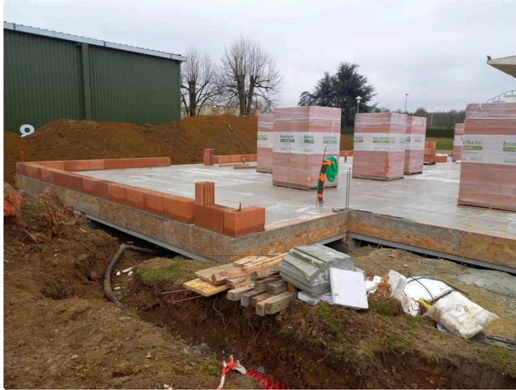
Au stade les travaux avancent
