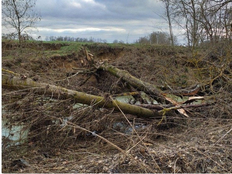
Travaux d'entretien de la rivière Gers et gestion des embâcles
