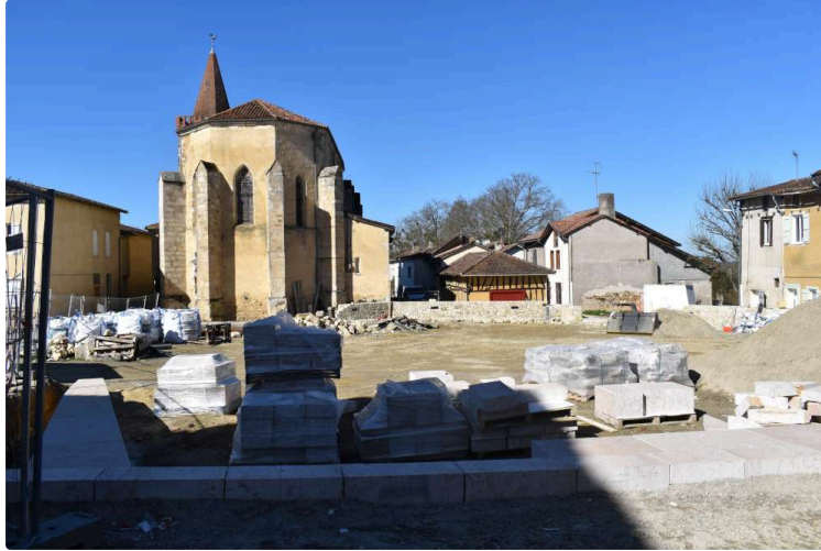
Le grand chantier est en cours
