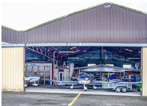
Autre hangar de l'aéro-club
