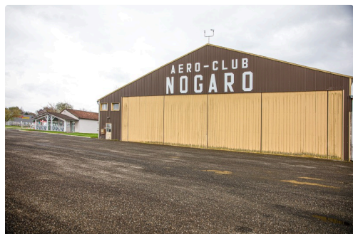
Bâtiment d'accueil (à gauche) et hangar de l'aéro-club
