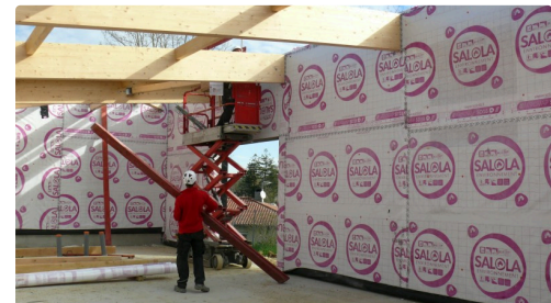
Préparation de la toiture.
