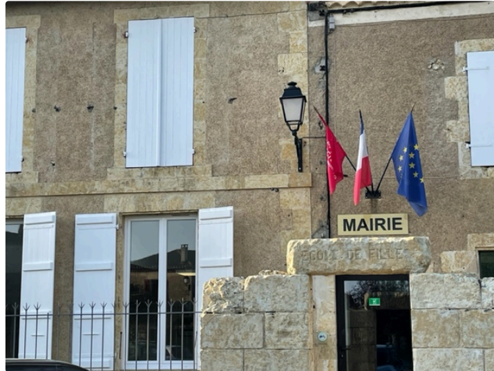
Réhabilitation de la mairie parmi les travaux 2021
