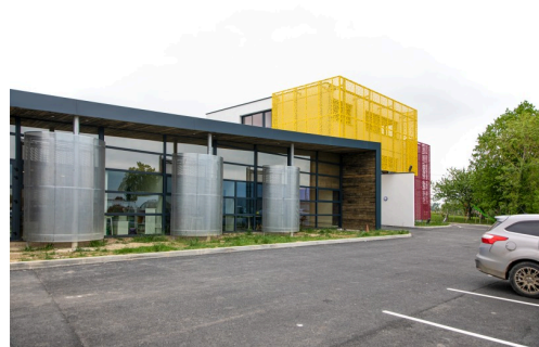
Autre côté de la façade
