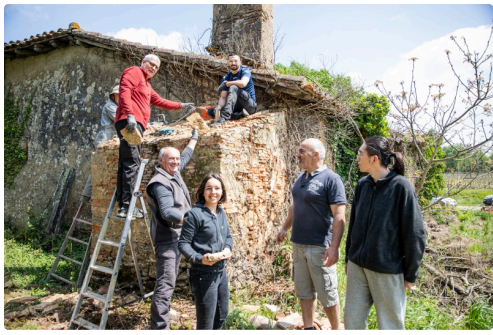
1 Le chantier avec Thierry Saint-Martin et Océane Gougeon à Sainte-Christie 1bis 300422.jpg
