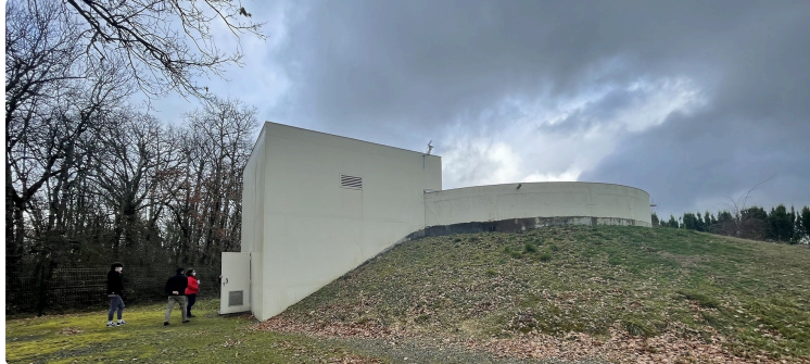
SIAEP de la région de Vic : nettoyage de châteaux d'eau
