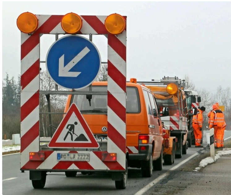
RN 124 : renouvellement chaussée
