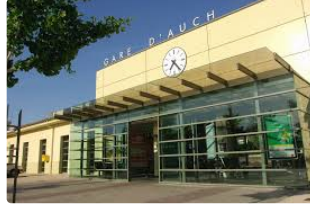
AUCH Accessibilité la gare d'Auch
