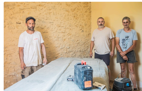
La salle de réunion en travaux avec Bertrand Priouzeau et Gérard Fitan le 15 juillet
