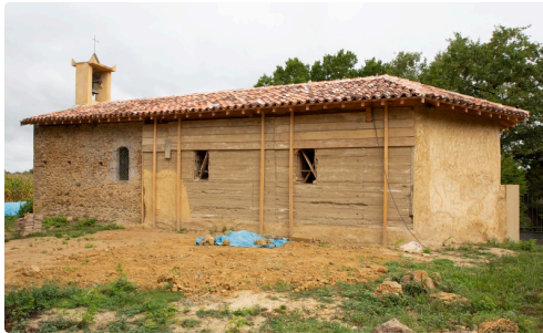
Église de Daunian pendant les travaux
