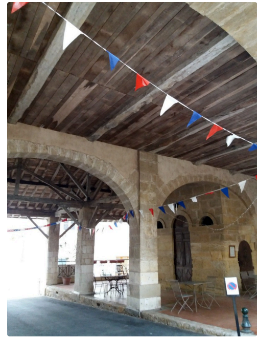
jegun halle 2.jpg
