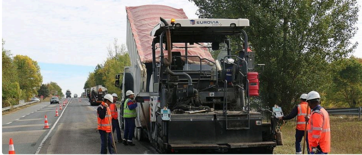
Travaux sur la RN 124
