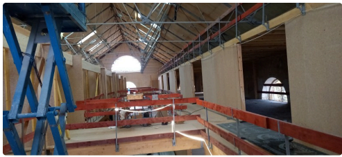
Vue du 1er étage.
