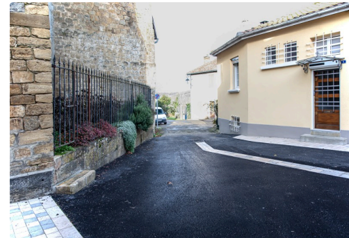
Descente de la rue Saint-Saturnin vers la droite depuis l'église
