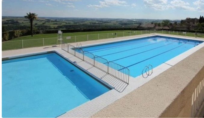
Réunion publique d'information : Les premiers résultats de l'étude de faisabilité pour la réhabilitation de la piscine
