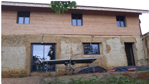
Maison pendant travaux crédit Ph M. Néron
