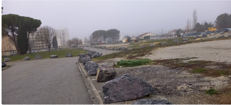
Le futur centre commercial du Garros rentre en phase active
