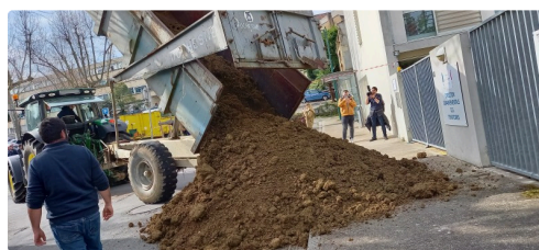
Premier camion à verser la terre.
