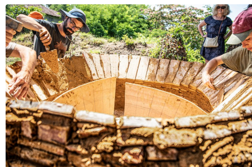
Le four en cours de reconstruction
