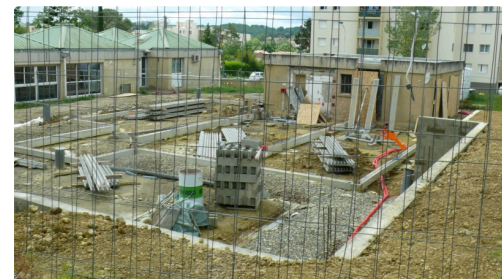
Les fondations de la nouvelle crèche.
