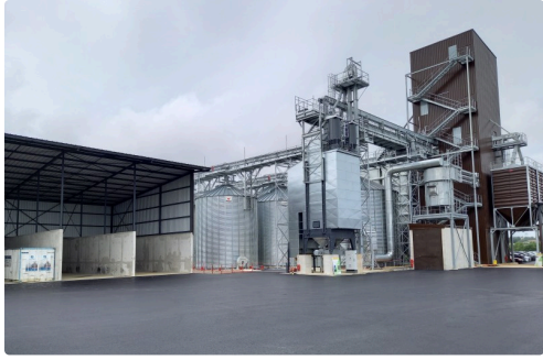
Une partie du silo.
